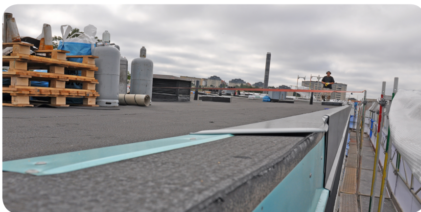
Byte av takduk och takfönster i Sundbyberg
